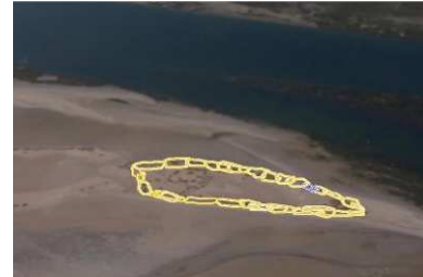
Photo 3 : Vue du site de nidification des spatules de l'île de Nair (PNBA) totalement réhabilité et protégé contre la submersion.
